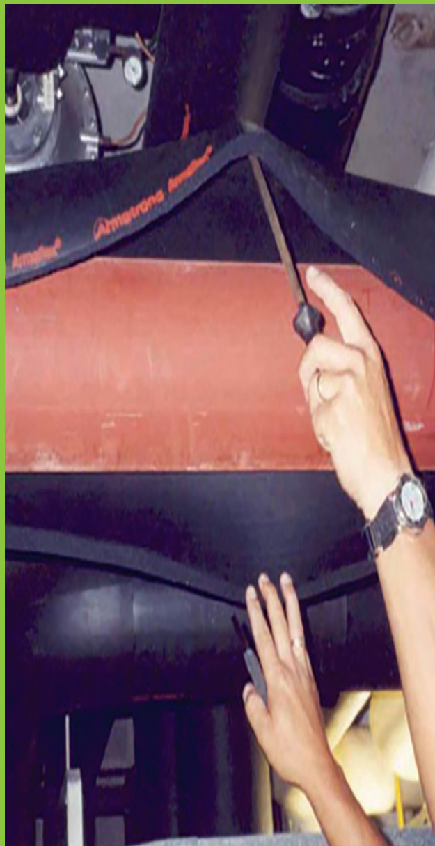
Рис. 7. Данный трубопровод холодной воды был защищен Armaflex в течение 20 лет – на фотографии показан профилактический осмотр исходной системы
