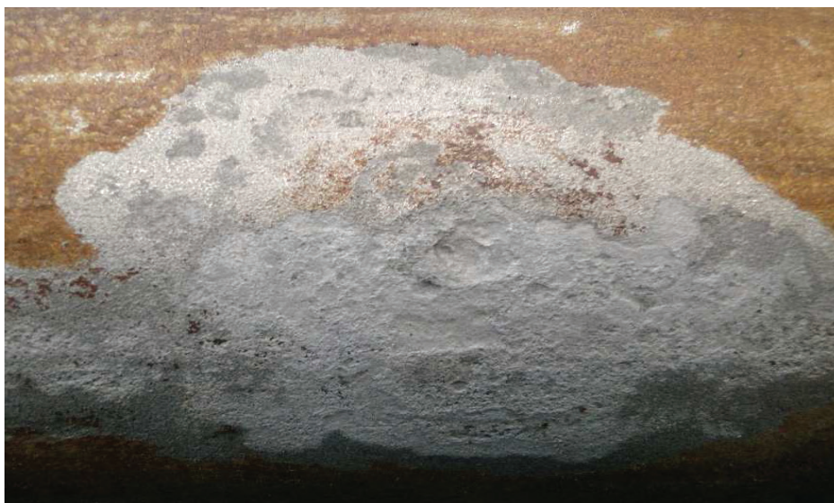
Рис. 5. Крупным планом показан очаг самой глубокой части коррозии (труба А)
