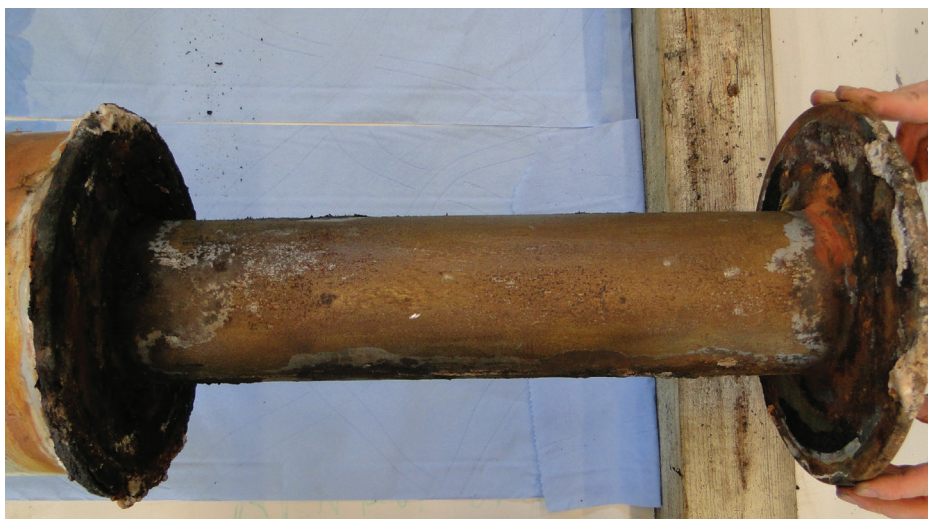
Рис. 4. Фото поверхности трубы под изоляцией
